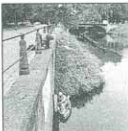
La pose des lignes de vie a débuté la semaine dernière.
